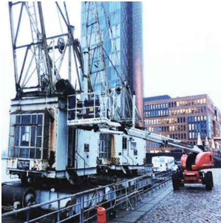
Sicherungsarbeiten an den Wipp-Kranen.
